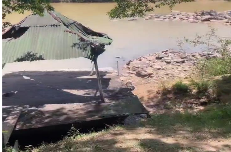
FIGURA 4 – Edificação às margens do rio caiapó
