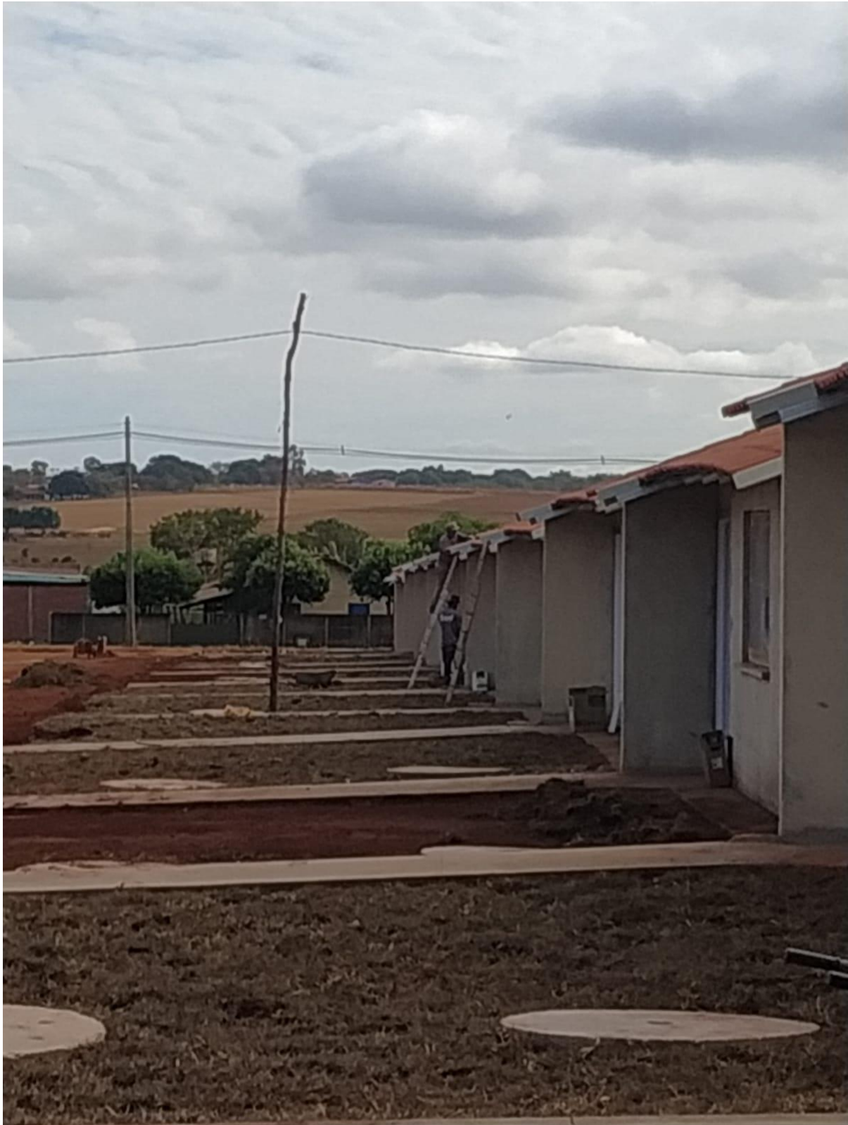
Figura 09: Trabalho em altura com EPI's e escada. Fonte: Própria, 2022.
