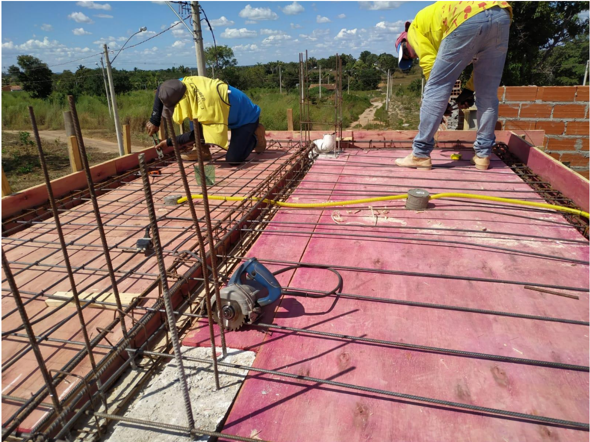
Figura 06: Trabalho em altura com bota e camisa de manga longa e sem cinto de altura. Fonte própria,2022.
