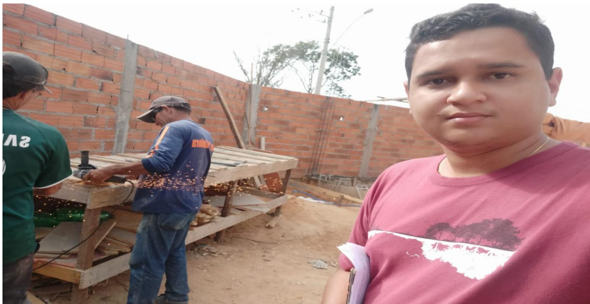
Figura 05: Uso de ferramenta cortante com o uso de EPI não correspondente a execução. Fonte: Própria, 2022.
