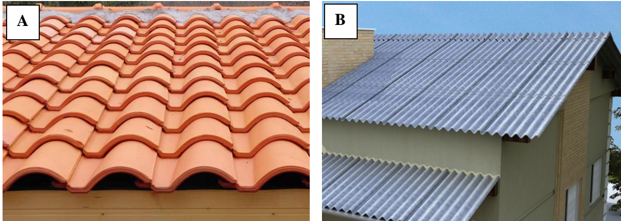
Figura 3: Telhados em cerâmica (A) e telhados em fibrocimento (B). Fonte: https://www.guiadoconstrutor.com.br/blog/6-principais-tipos-de-telhas-de-ceramica-para-nao-errar-no-telhado e https://www.totalconstrucao.com.br/inclinacao-telha-fibrocimento/
