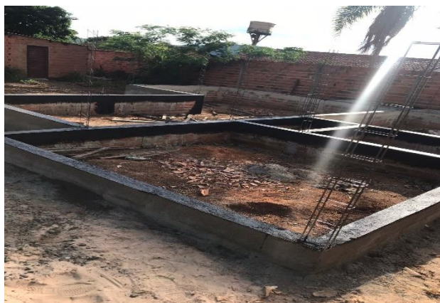
Figura 3 - Obra que optou pela impermeabilização da viga baldrame Fonte: Própria, 2021
